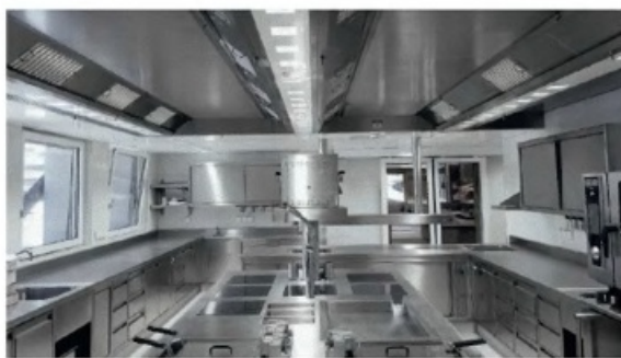
Рисунок 24 – Пример вентилируемого потолка
