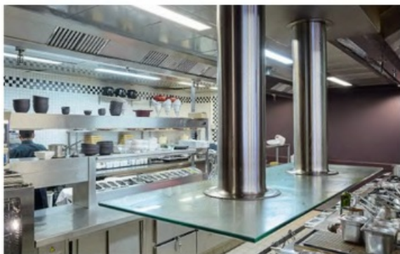
Рисунок 27 – Пример использования комбинации вентилируемых потолков и местных отсосов
