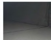
Вентиляционный канал после 6 месяцев использования генератора OZART
